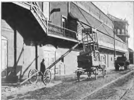
Fig. 224. Setzen von Masten mittels Turmwagens bei der Philadelphia R. T. Co.
